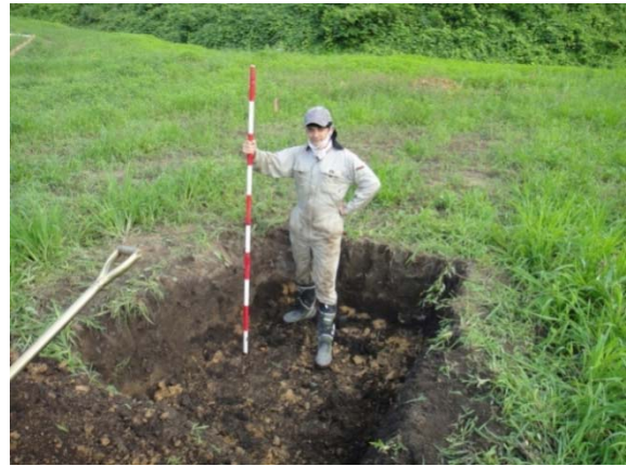
写真 5.3.2.1-11 R6 土砂トラップ の設置風景 (測量)
