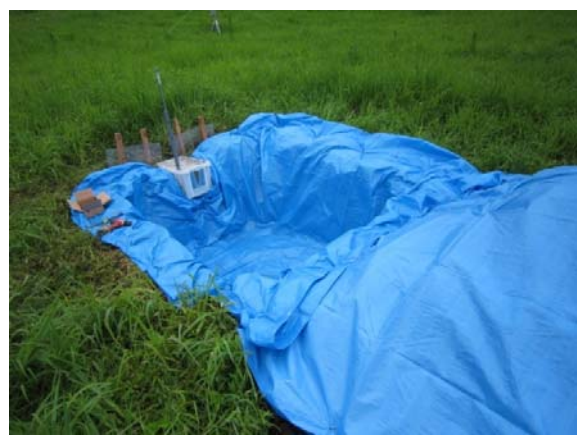
写真 5.3.2.1-13 土砂トラップの概観
