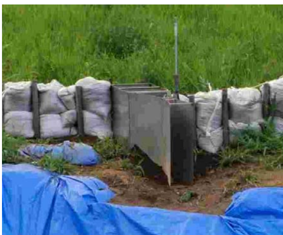
写真 5.3.2.1-14 ガリー土砂トラップに 設置したパーシャルフリューム量水堰
