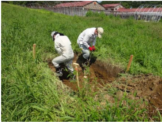
写真 5.3.2.1-10 R8 土砂トラップの設置風景 (掘削)
