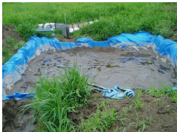
写真 5.3.2.1-20 排水したガリートラップ
