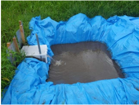
写真 5.3.2.1-15 水土砂が流入する 土砂トラップ
